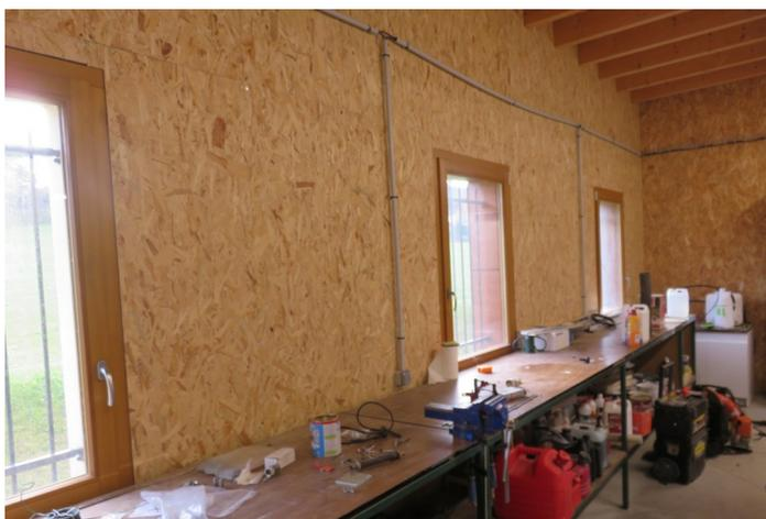
Un doublage en laine de verre de 60 mm d'épaisseur a donc été effectué et le choix d'un revêtement OSB a été préféré à un doublage Placoplatre. Même si ces plaques sont plus onéreuses que les classiques plaques de plâtre, leur résistance mécanique est meilleure (d'où un gage de longévité pour ce genre de local) et apporte de surcroît une résistance thermique supplémentaire donc une meilleure isolation.
