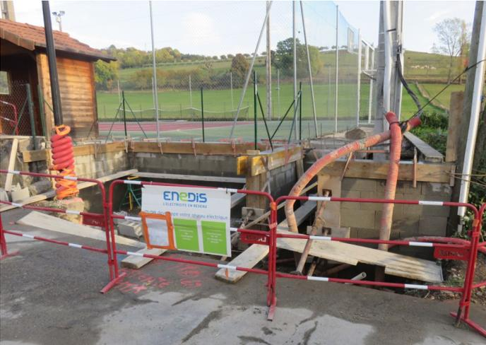
Pour information ces travaux ont eu pour finalité d'alimenter en électricité le futur lotissement situé en aval de l'église et de la mairie actuelle. Pour cela, l'ancien transformateur a été remplacé par un transformateur plus puissant ce qui a nécessité quelques travaux de maçonnerie et de voirie.
