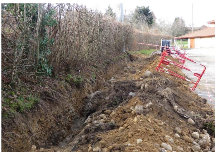
*Les tranchées réalisées dans l'accotement de la salle des fêtes ont permis de ne pas dégrader le revêtement du parking.*
